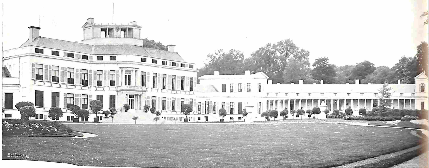
SOESTDIJK (VOORGEVEL EN LINKERLEUGEL.)
