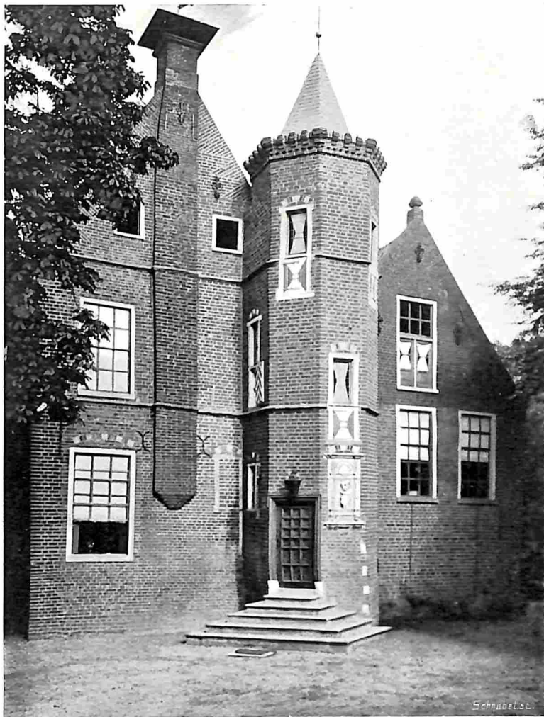
Foto R. H. Herwig. DE WEDDERBURCHT. VOORGEVEL.
