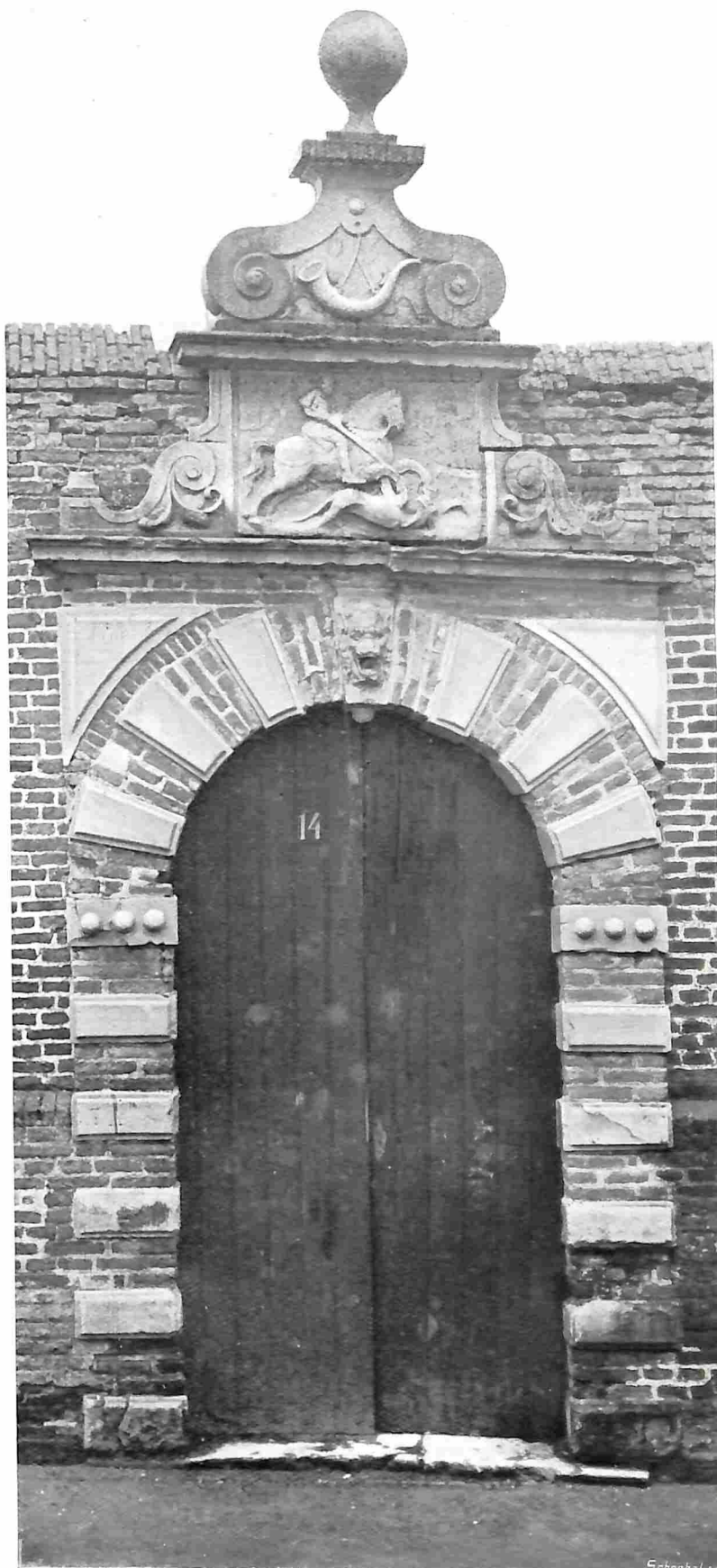
POORTJE MET ST. JORES, VAN HET DOELENPLEIN TE HOORN, DAT MET HET OP BLZ. 59 AFGEHEELDE ST. SEBASTIAAN- POORTJE, BIJ DE BEBOUWING VAN HET TERREIN GEHEEL AFGEBROKEN WERD, OM NA GERESTAUREERD TE ZIJN, OPGEBOUWD TE WORDEN BIJ DE NIEUWE GYMNASIEK- SCHOOL TE HOORN.
