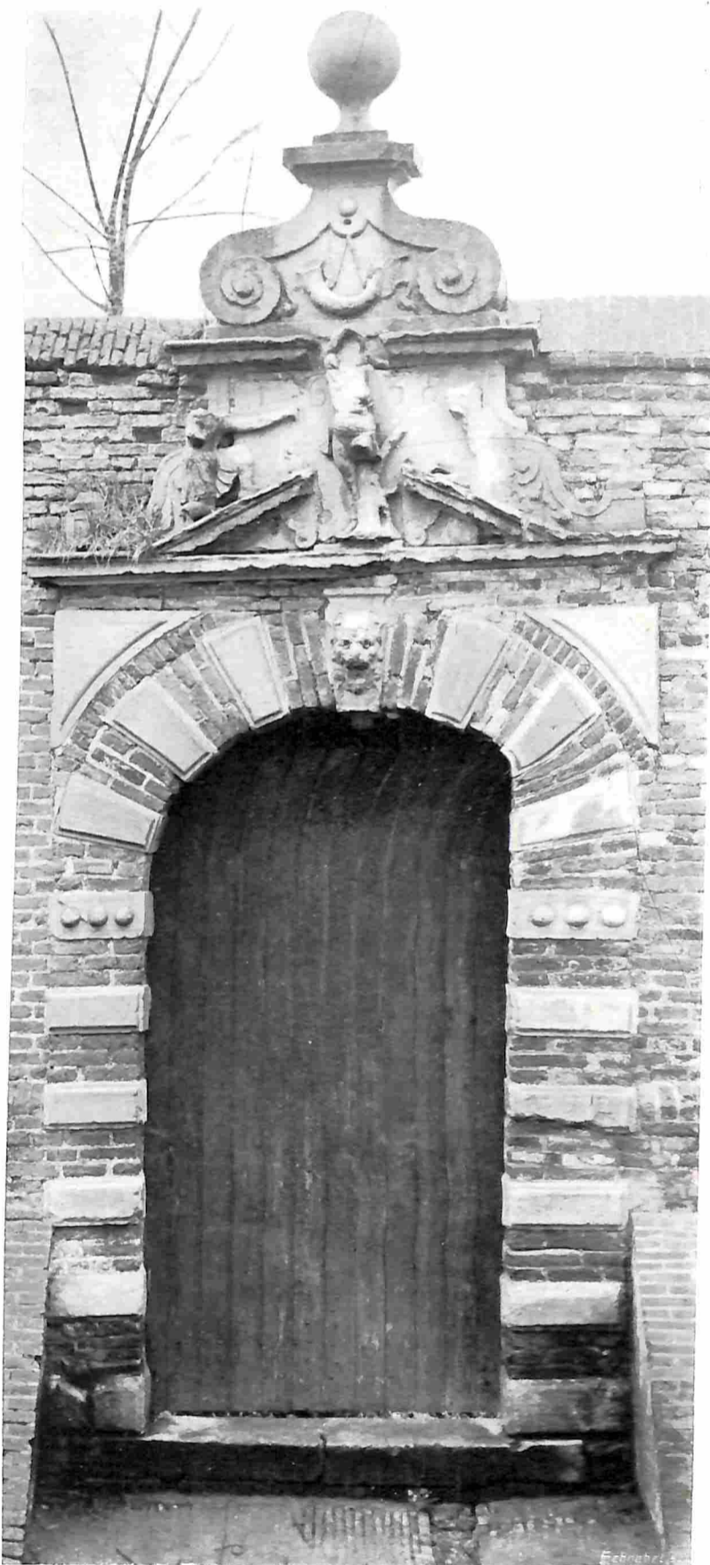
HET ST. SEBASTIAANPOORTJE VAN HET DOELENPLEIN TE HOORN, vóór de restauratie.
