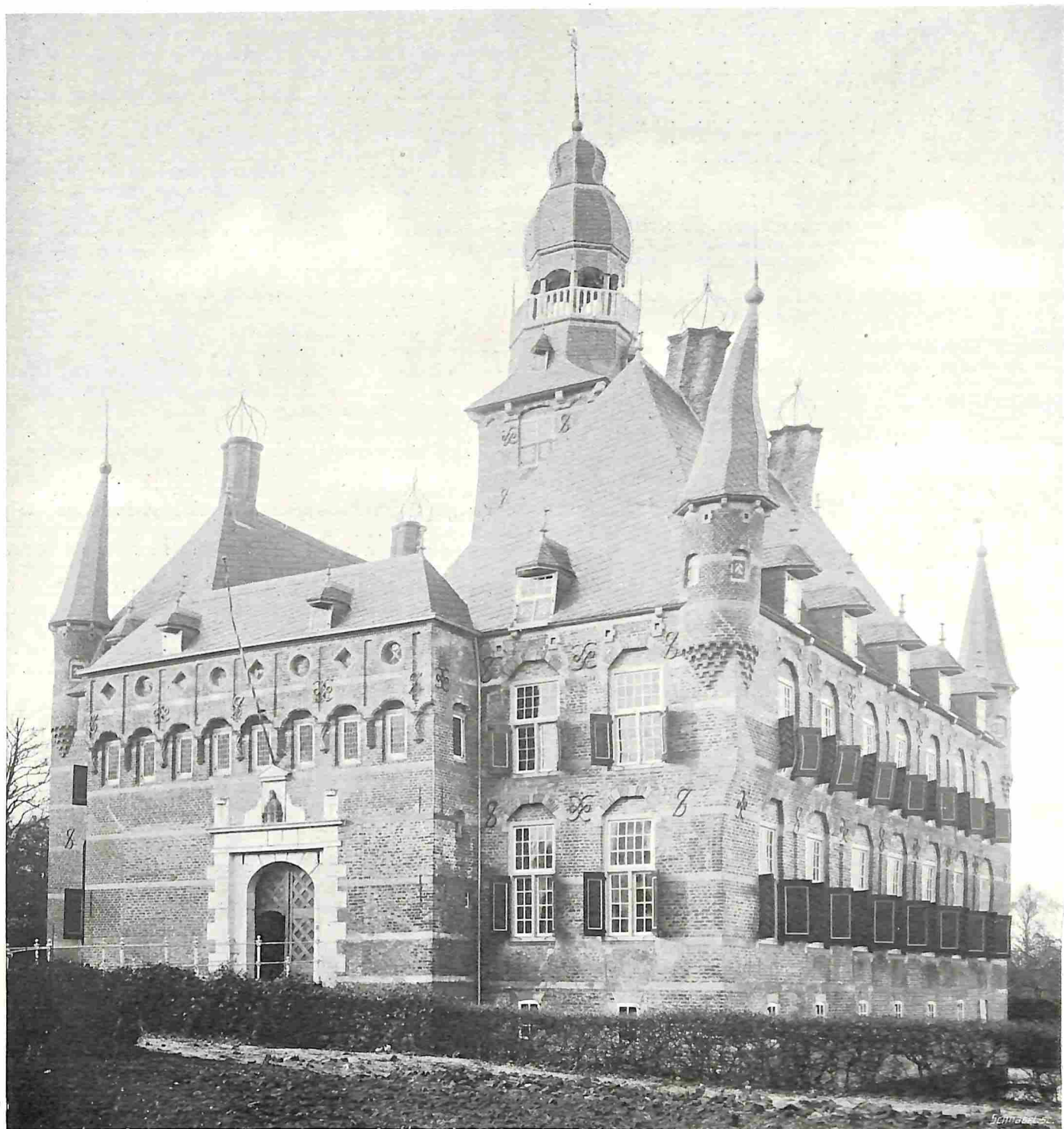
HET KASTEEL VAN WIJCHEN. (N.-BR.) VOORGEVEL Z.O. BOVEN DE INGANGSPOORT BEVINDT ZICH DE OUDE SLOTKAPEL.
