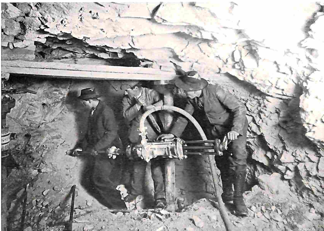
DE JUNGFRAUTUNNEL. LUCHTDruk-BOORMACHINE, SYSTEEM INGERSOLL.
