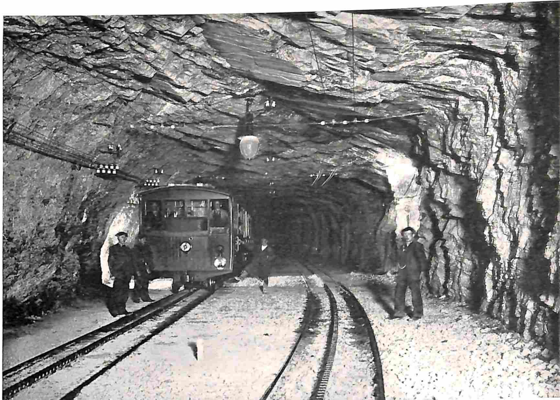
DE JUNGFRAUTUNNEL. TUNNELSTATION EISMEER.
