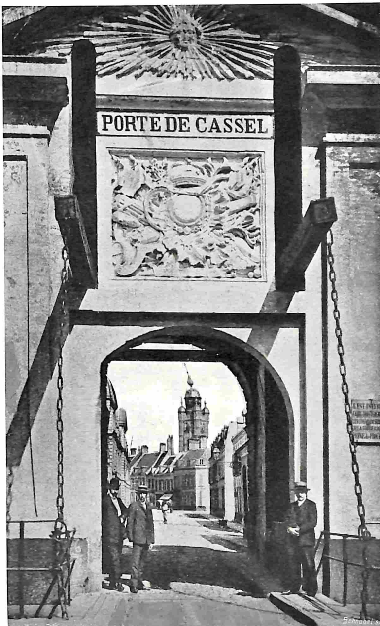
EEN MERKWAARDIGE LANDSTREEK TUSSCHEN YPEREN EN CALAIS. DE CASSELSCH POORT TE ST. WINOCKSBERGEN (BERGUES, MET KIJKJE IN DE ZUIDSTRAAT.
