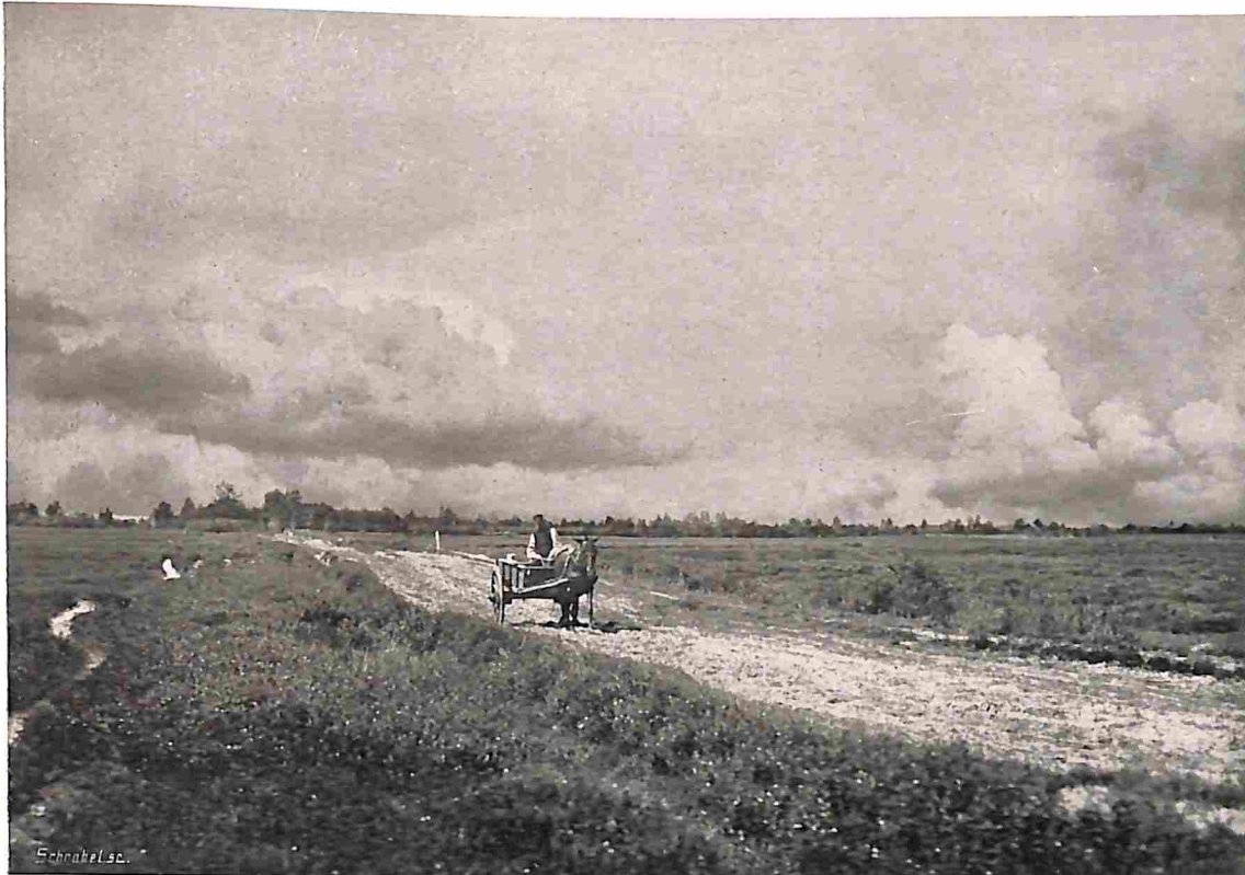
DE WANDELWEG ZWOLLE—OLDENZAAL. BIJ DENEKAMP. OP DE HEIDE.
