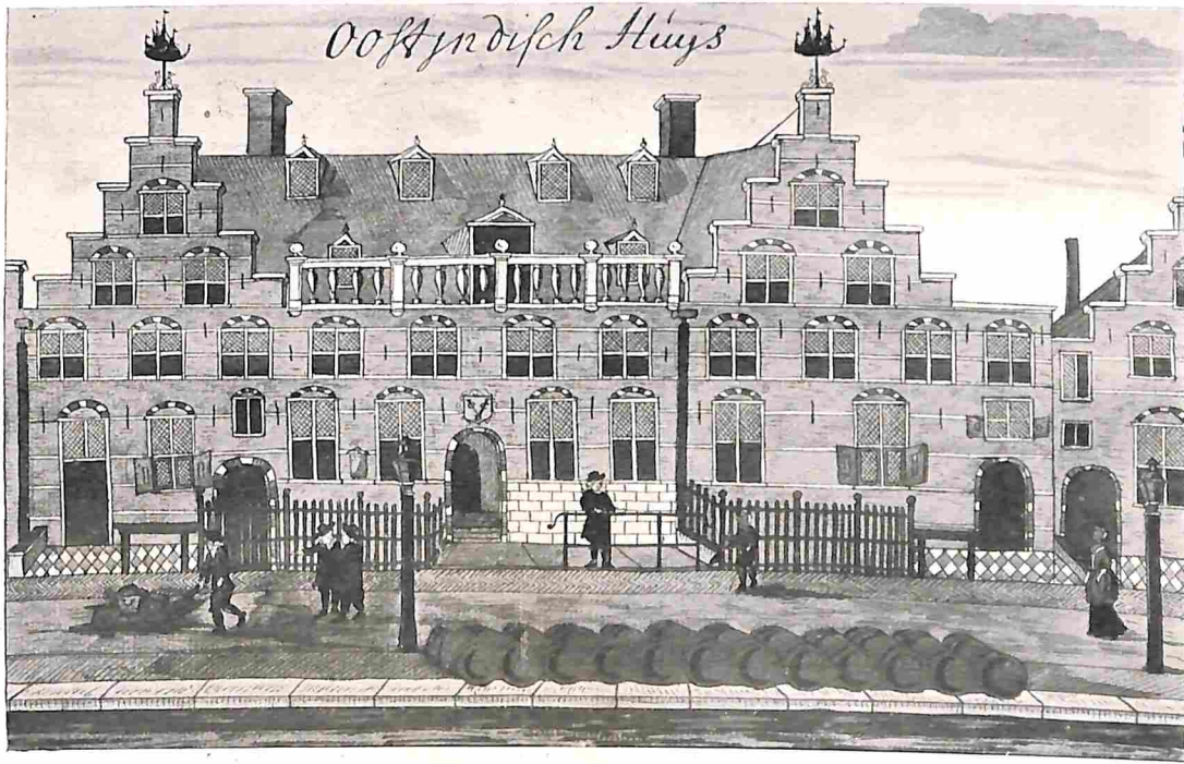
HET OOST-INDISCH HUIS TE DELFT, VÓÓR DE VERBOUWING VAN 1722.
