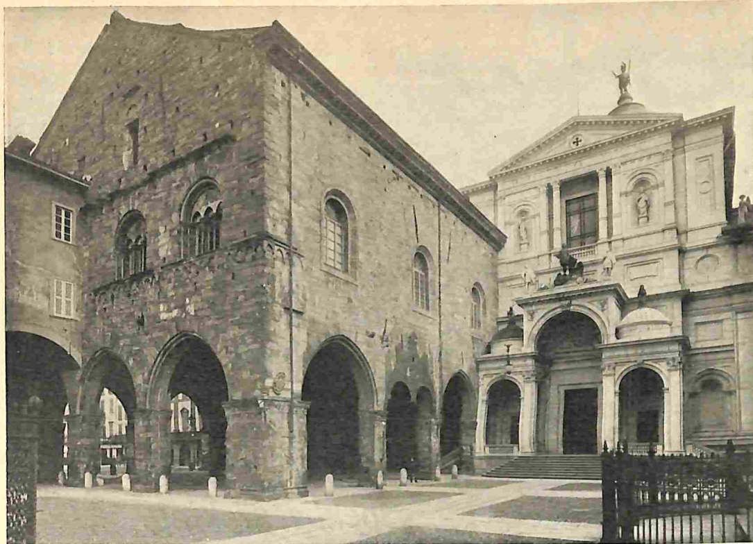
BERGAMO. VOORGEVEL VAN DE KATHEDRAAL EN HET BIBLIOTHEEK- GEBOUW (VOORMALIG PALAZZO VECCHIO).
