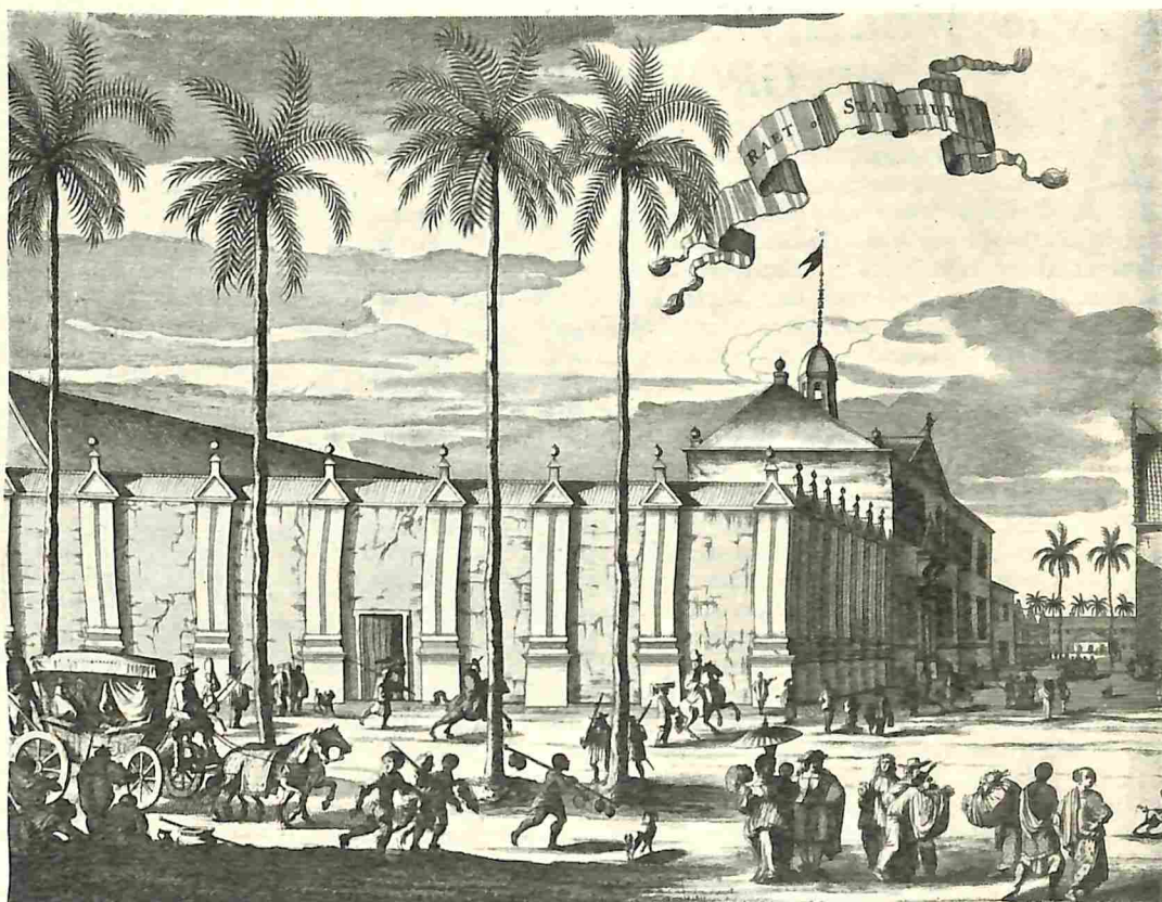
HET STADHUIS TE BATAVIA, VOLTOOID IN 1652, VERVANGEN DOOR HET TEGENWOORDIG NOG BESTAAND GEBOUW IN 1710.
