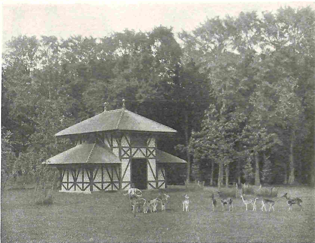
IN DEN ALKMAARDERHOUT. HET HUISJE VAN DE HERTEN.
