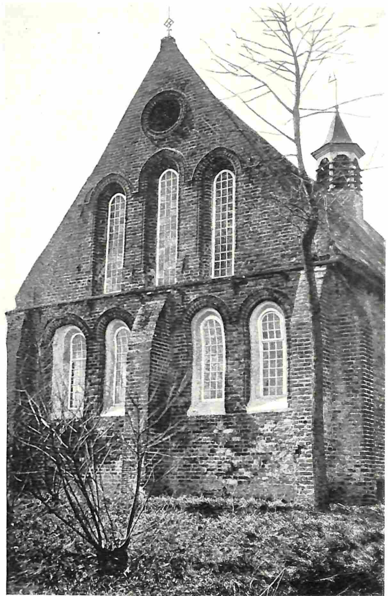
EEN OUDE KLOOSTERKAPTEL. DE OOSTELIJKE ZIJGEVEL.
