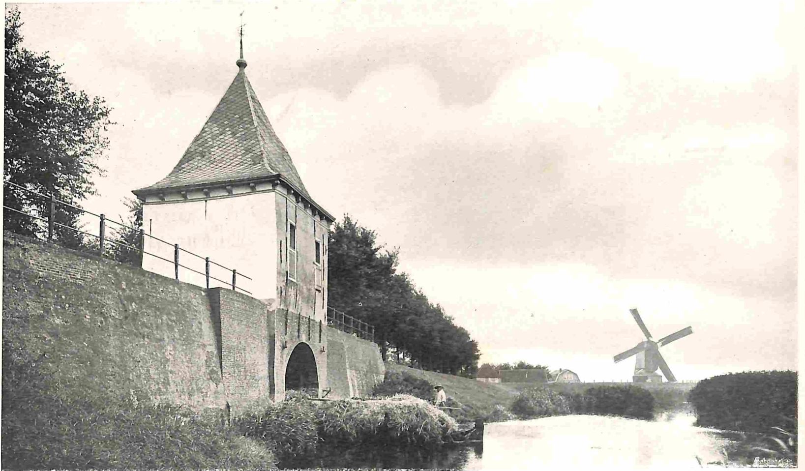
GESLOTEN STANDERDMOLEN BIJ DE „OUDEGOUWSBOOM" TE ENKHUIZEN.
