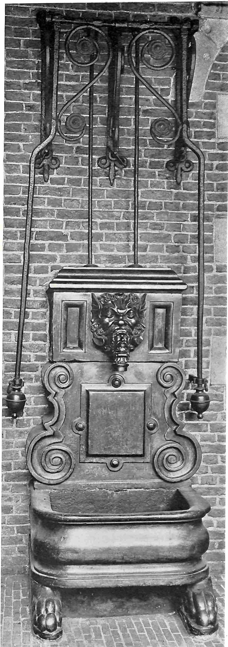
HET MUSEUM PLANTIJN. DE POMP OP DE BINNENPLAATS.
