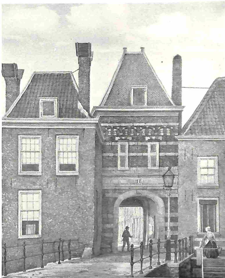
DE ST. JORISPOORT, BUITENZIJDEN. AFGEBROKEN IN 1874.
