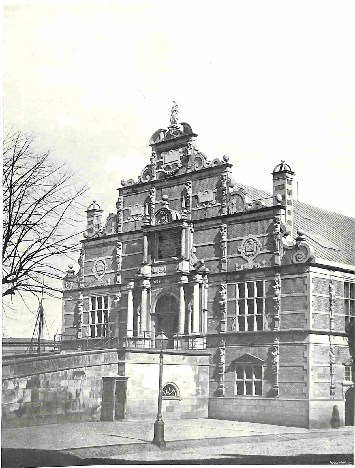
DE WESTELIJKE GEVEL VAN DE BEURS TE KOPENHAGEN.
