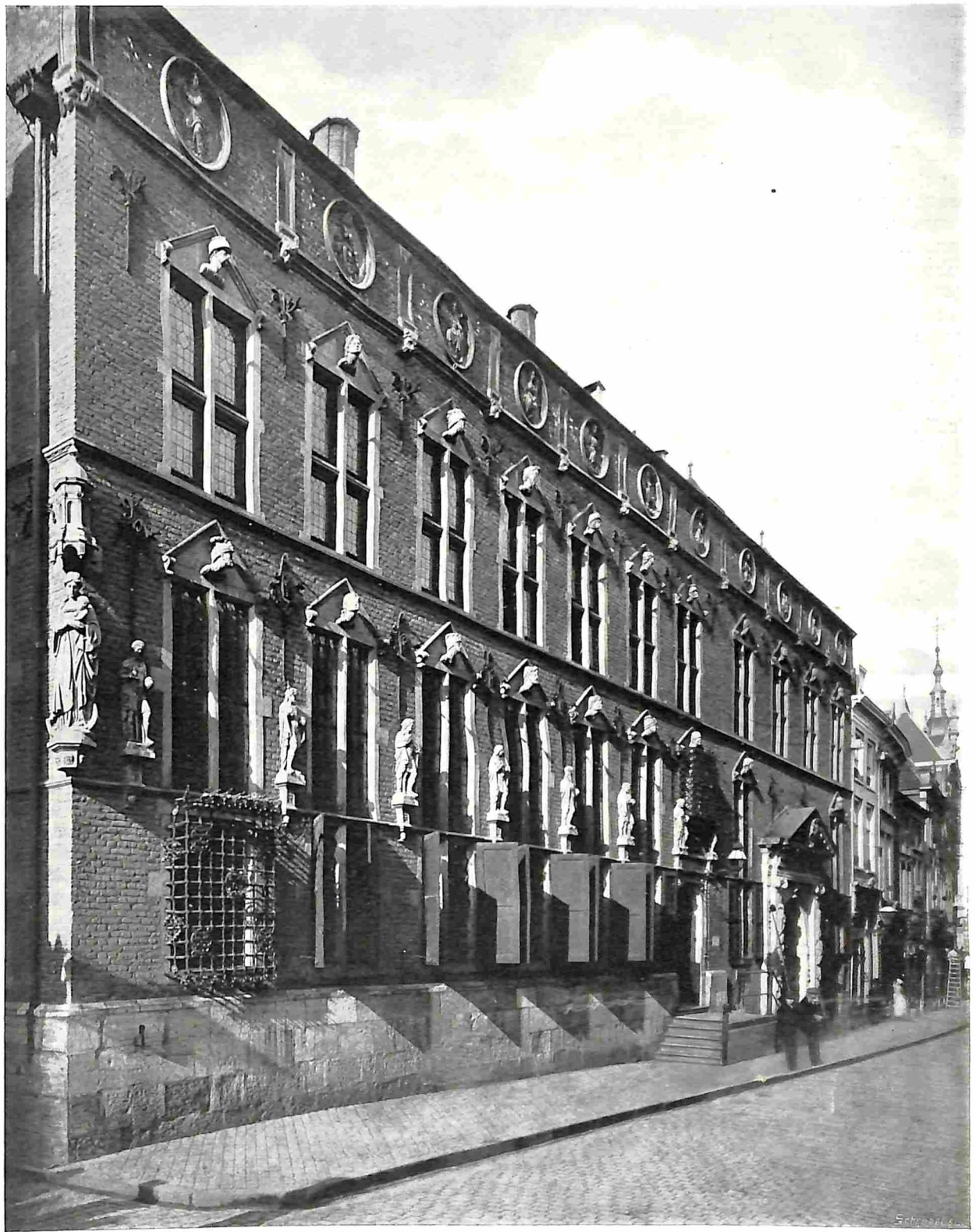
DE VOORGEVEL VAN HET RAADHUIS TE NIJMEGEN.
