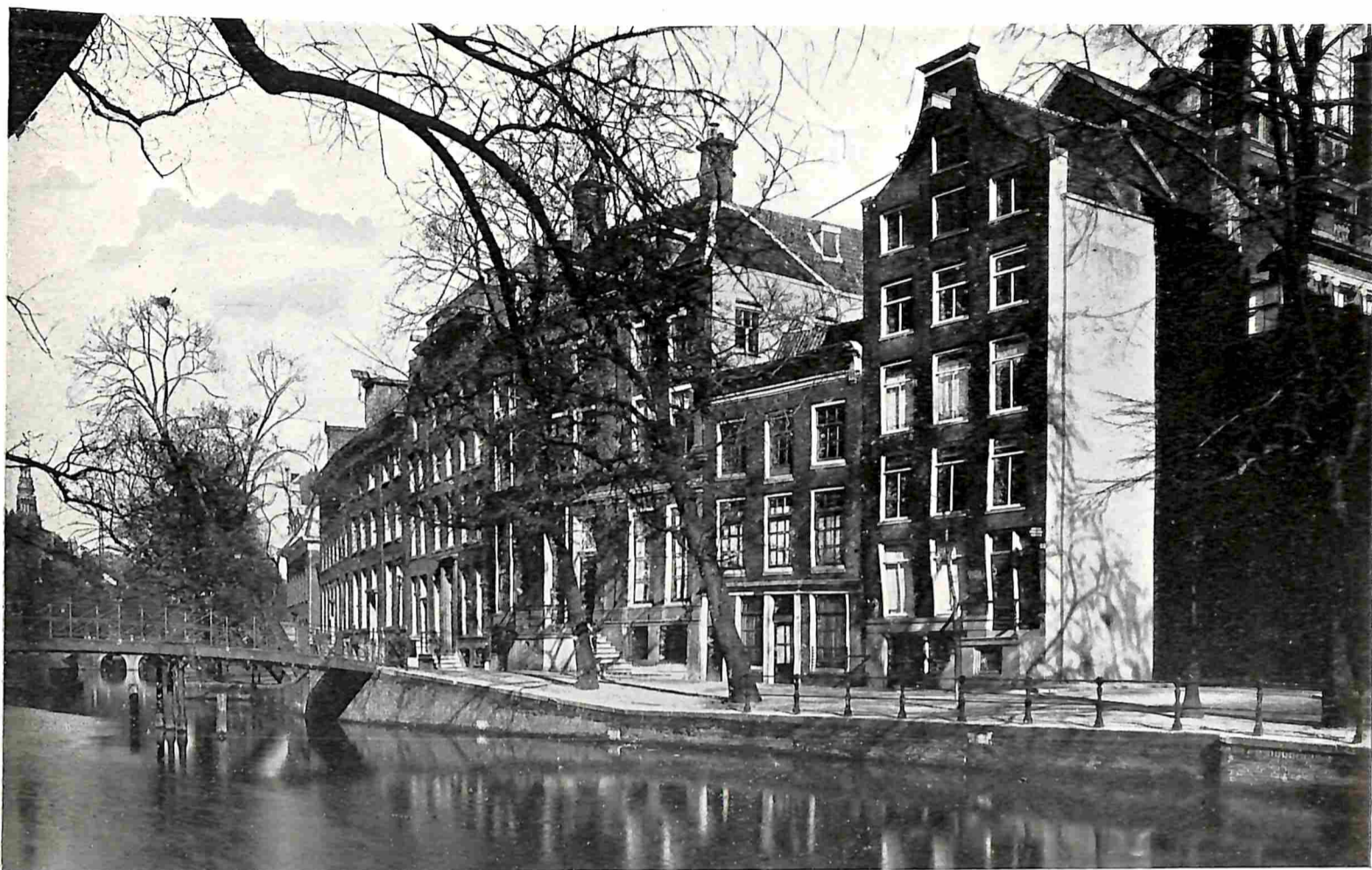
HUIZEN AAN DEN OUDEZIJD'S VOORBURGWAL, GESLOOPT VOOR DE VERBOUWING VAN HET RAADHUIS.
