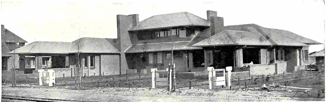
KIJKDUIN. DRIE SAMENGEBOUWDE LANDHUIZEN IN HET VILLAPARK.
