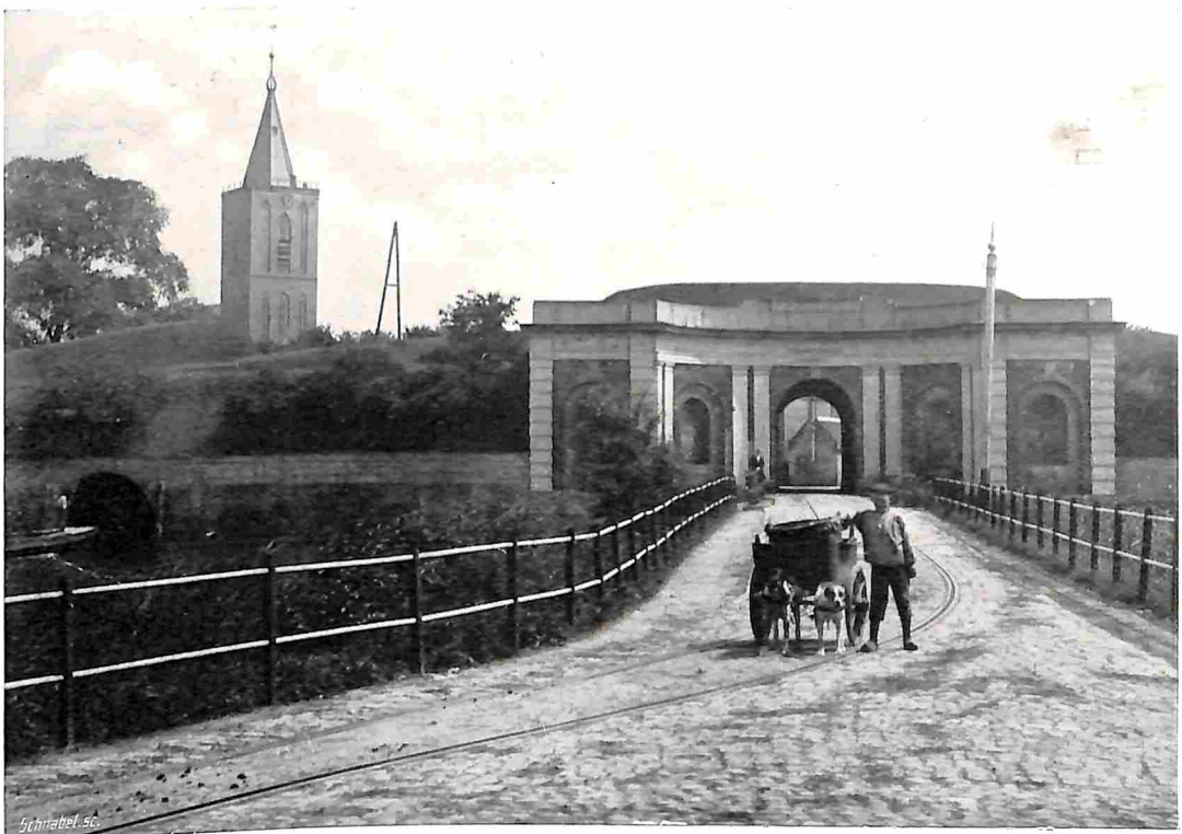
DE IN 1915 GESLOOPTE AMSTERDAMSCH E POORT VAN 1683.
