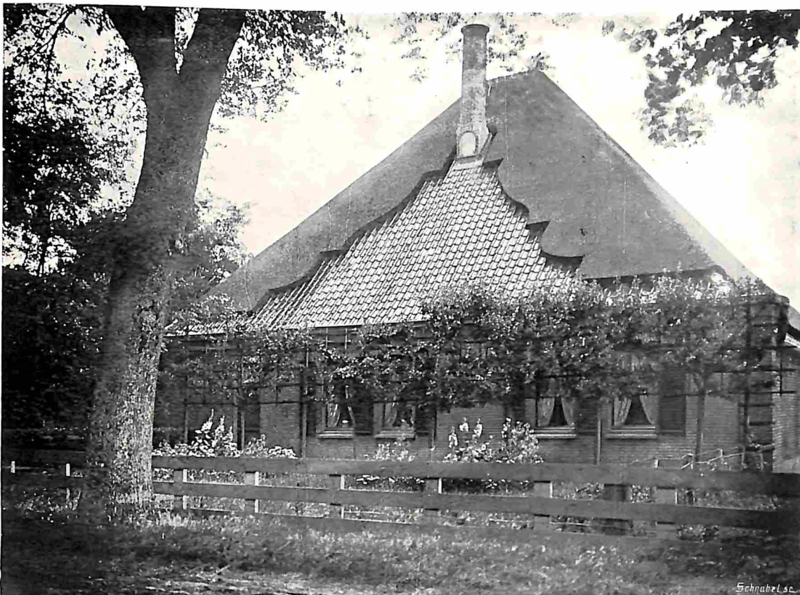
TERZIJDE VAN „DE STREEK”. EEN WEST FRIESCHE BOERDERIJ MET UITGEDEKT RIETEN DAK
