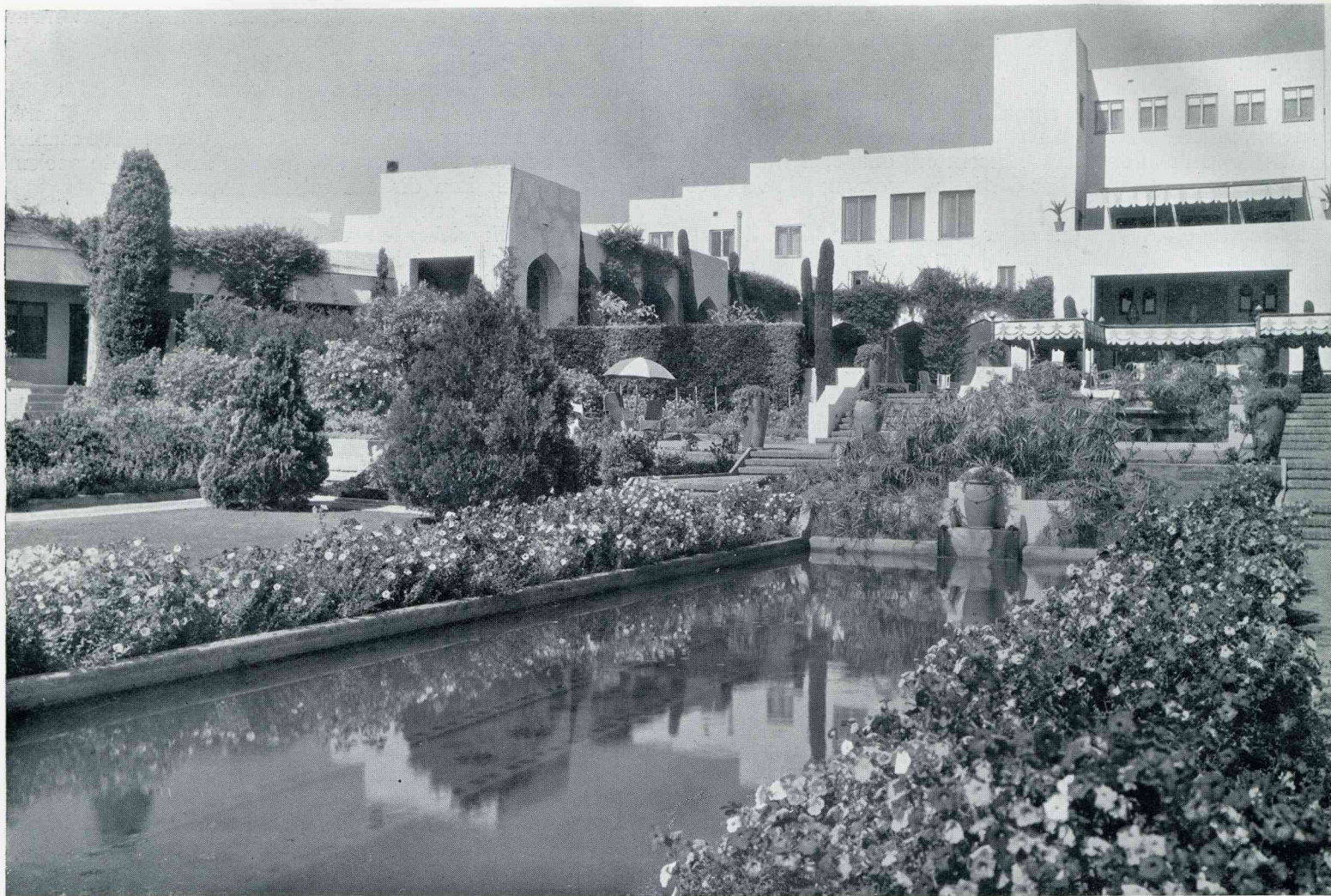
BINNENHOF VAN HET IN PERZISCHEN STIJL GEBOUWDE SAMARKAND-HOTEL TE SANTA BARBARA
