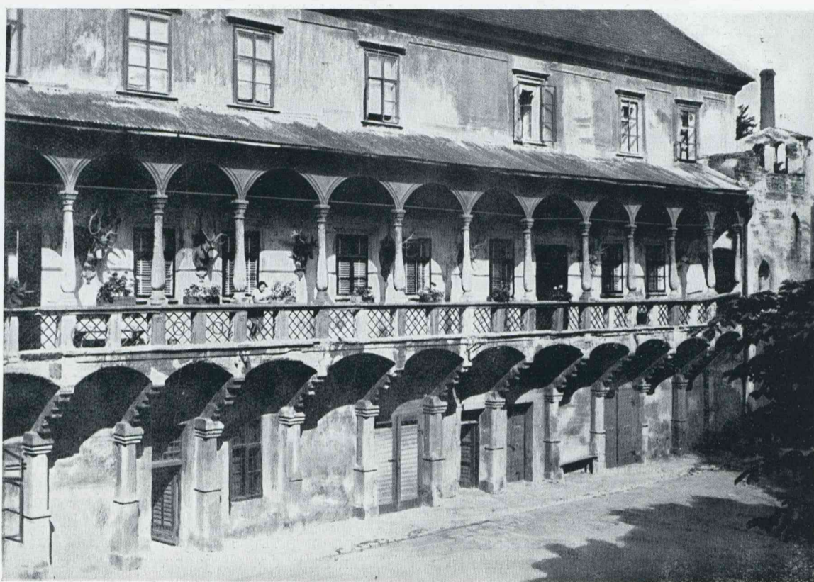
BINNENHOF VAN DEN BURCHT BŘECLAV
