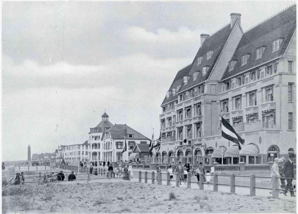
DE NOORD-BOULEVARD TE NOORDWIJK-AAN-ZEE
