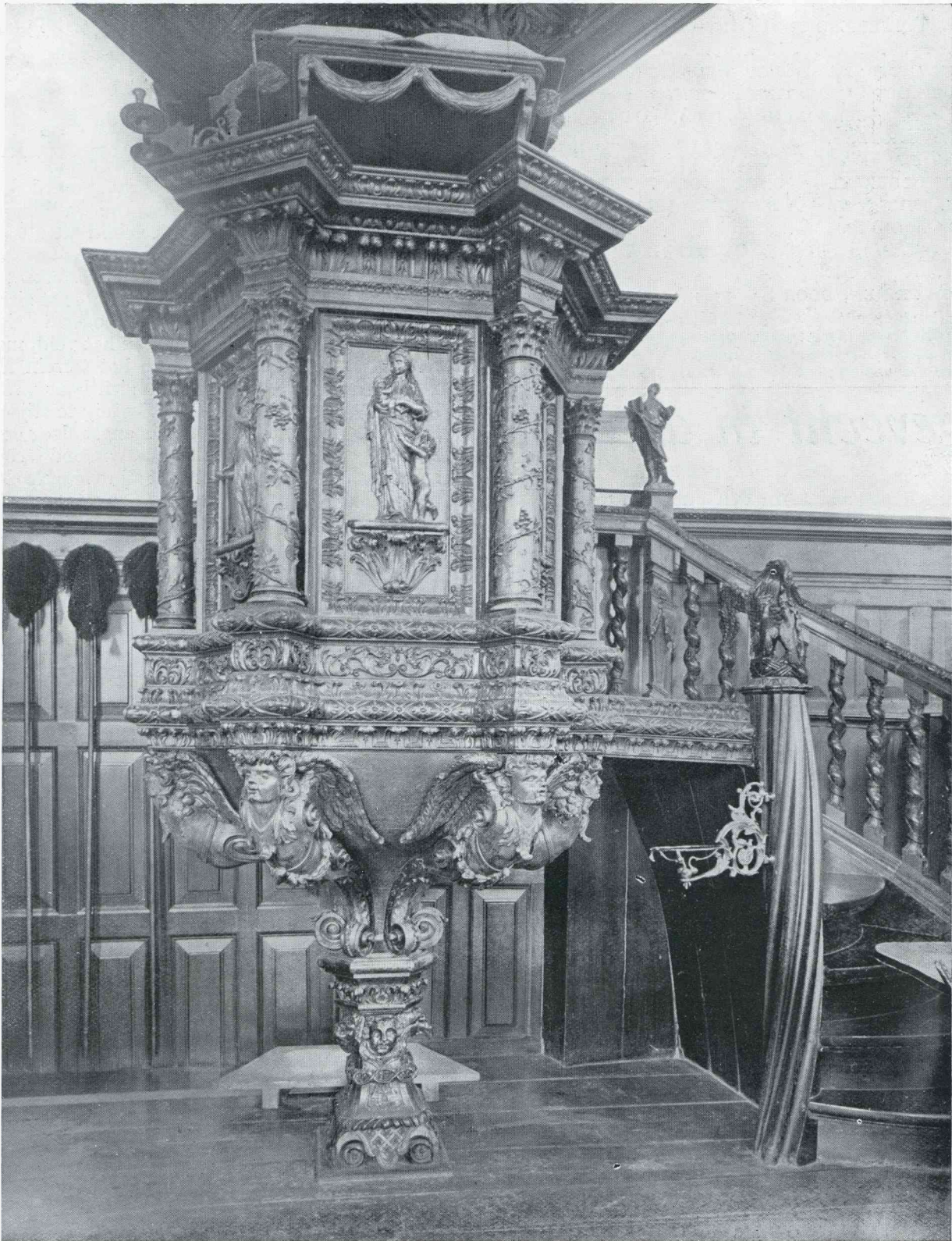
PREEKSTOEL IN DE NED. HERVORMDE KERK TE ST. ANNA-PAROCHIE, WELKE KERK 250 JAAR GELEDEN GEBOUWD WERD
