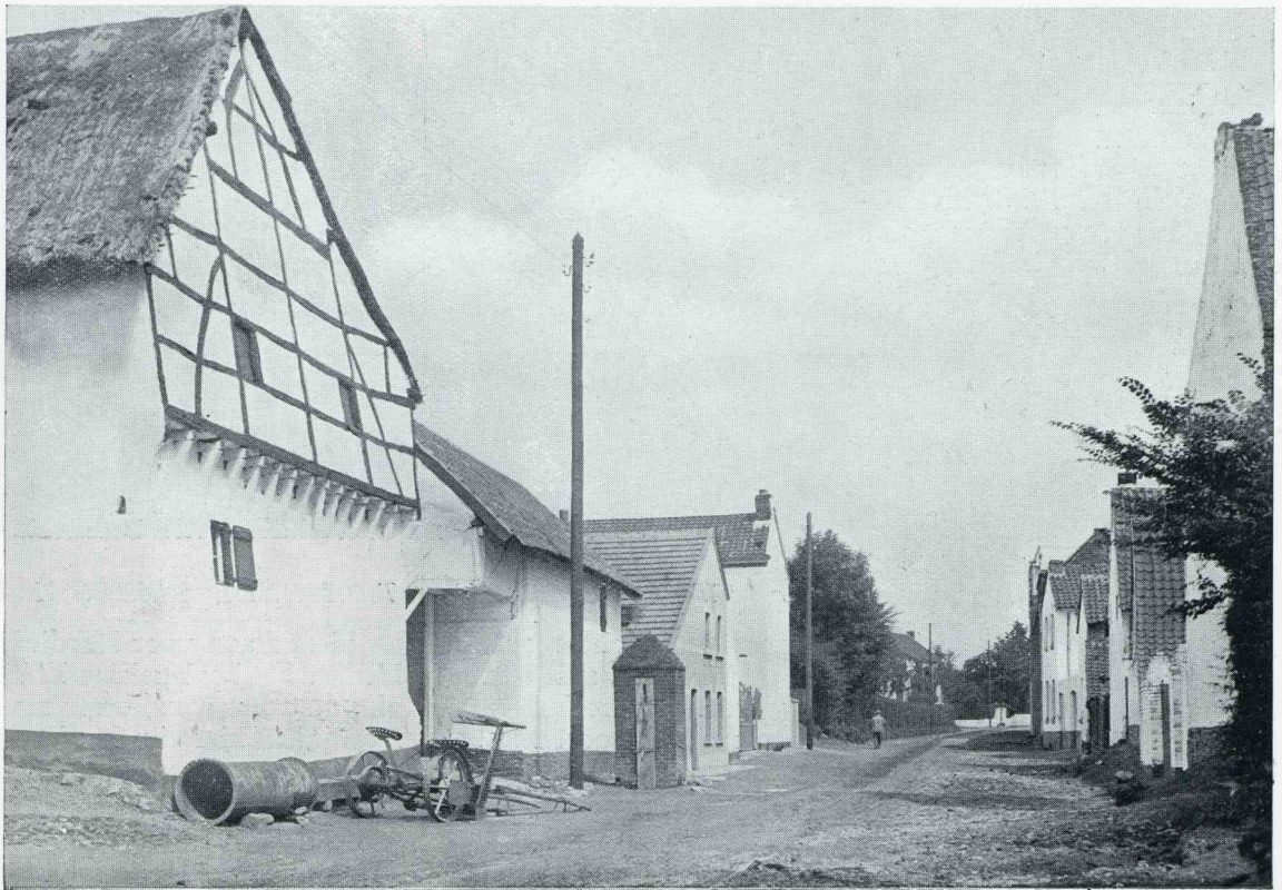
LIMBURGSCHE BOERDERIJEN. DORPSTRAAT TE EYSDEN Voorbeeld van vakwerkbouw
