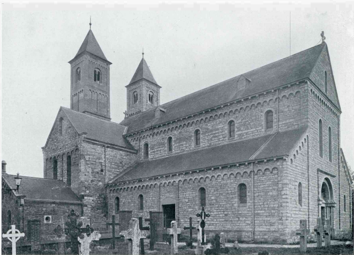
DE ONGEVEER ACHT EEUWEN OUDE ROMAANSCH, UIT MERGELSTEEN OPGETROKKEN KERK TE ST. ODILIËNBERG
