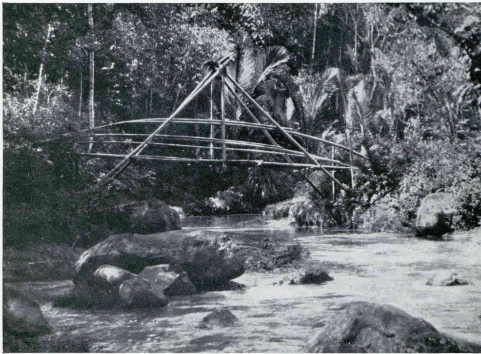
BAMBOE EN ZIJN TOEPASSINGEN. EEN EENVOUDIGER MODEL VAN EEN BAMBOEBRUG
