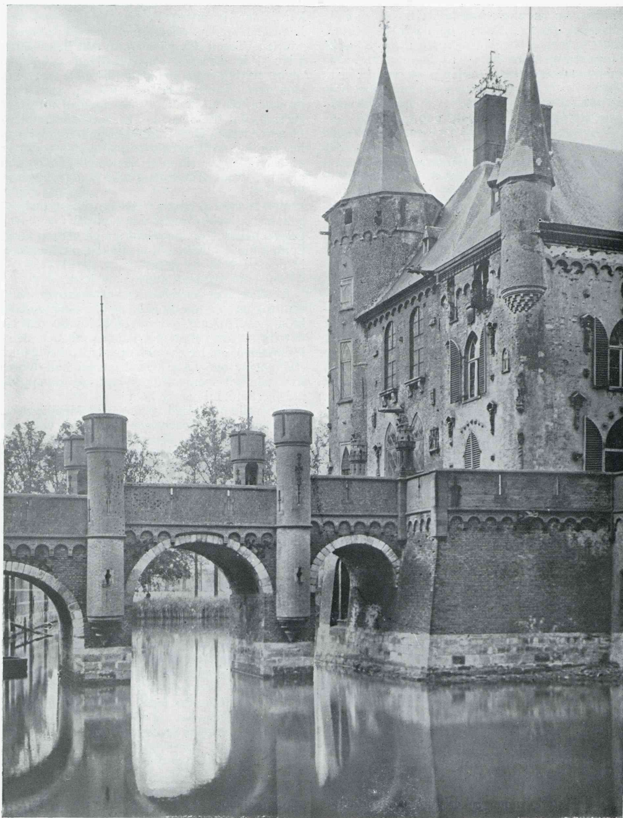
DE SLOTBRUG VAN HET KASTEEL TE HEESWIJK IN NOORD-BRABANT
