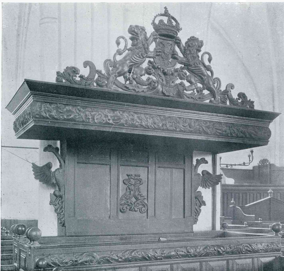
EEREGESTOELTE VOOR PLAATSELIJKE POTENTATEN IN DE KERK TE APPINGEDAM
