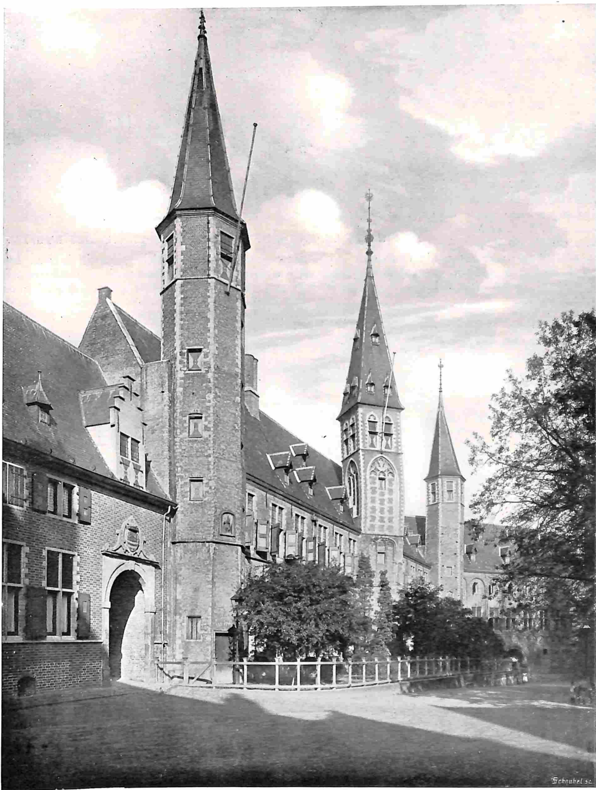
DE WESTELIJKE ABDIJGEBOUWEN AAN HET BINNENHOF; LINKS DE BURGPOORT EN OP DEN ACHTERGROND DE BALANSPOORT
