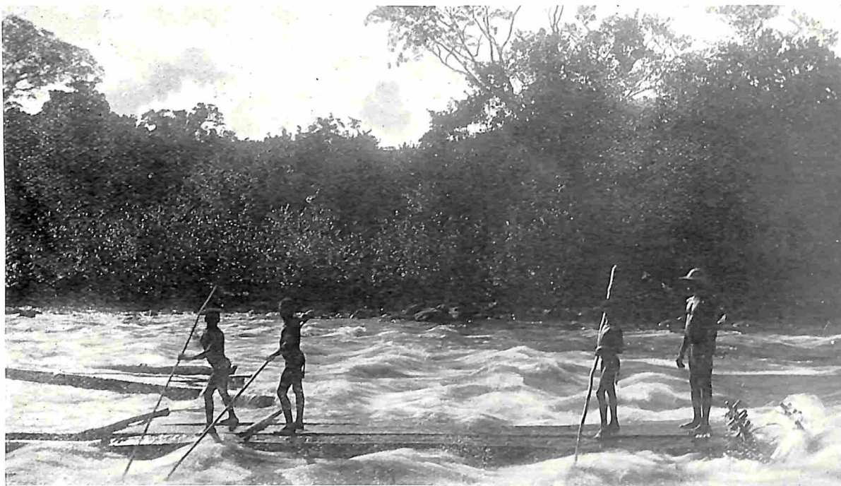
HOUTTRANSPORT DOOR DE BOSCHNEGERS OP DE BOVEN-SURINAME BALKEN, DIE SOORTELIJK ZWAARDER ZIJN DAN WATER EN DUS Zouden ZINKEN, WORDEN MET LICHTER HOUT OF TUSSEN KORJALEN DRIJVENDE GEHOUDEN. HET BESTUREN GESCHIEDT MET EEN LANGEN STOK, „KOELA” GENAAMD. MET ZULK EEN „KOELA” WORDEN OOK DE KORJALEN DOOR DE STROOMVERSNELINGEN IN DE BOVEN-RIVIEREN GESTUURD
