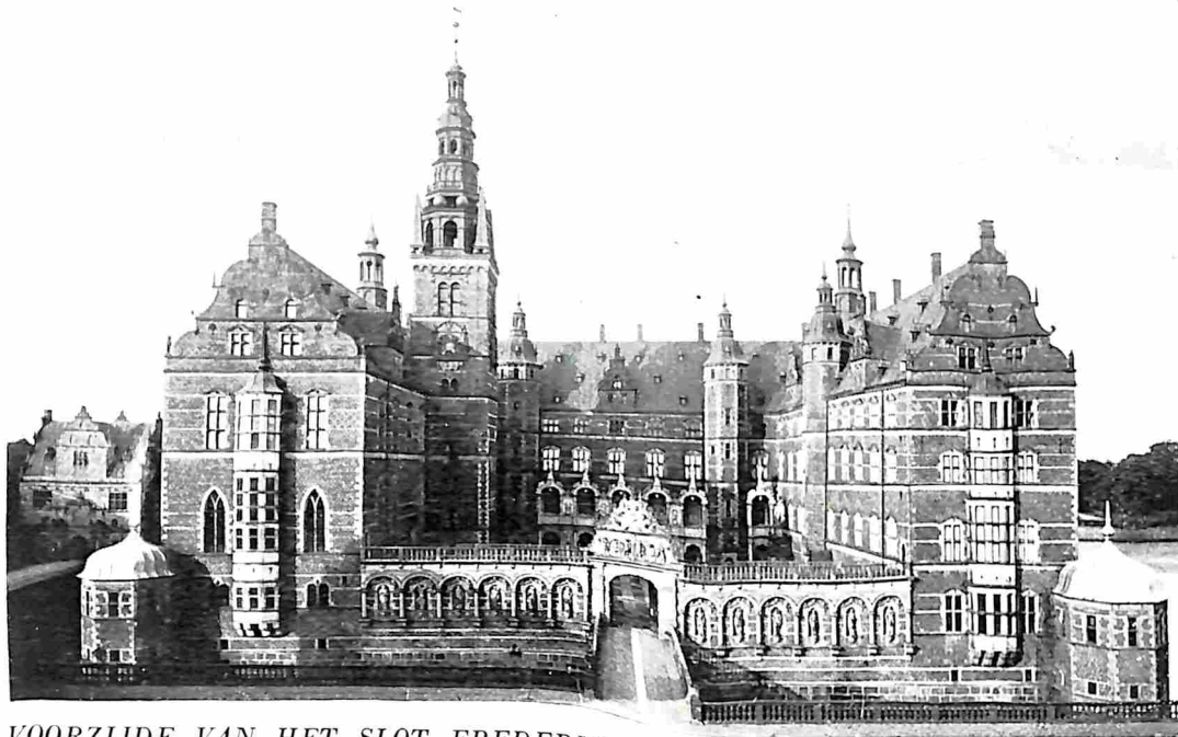
VOORZIJDEN VAN HET SLOT FREDERIKSBORG TE HILLERØD, IN NEDERLANDSCHE RENAISSANCESTIJL GEBOUWD
