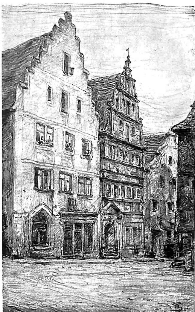
HET BAUMEISTERHAUS IN DE SCHMIEDGASSE
