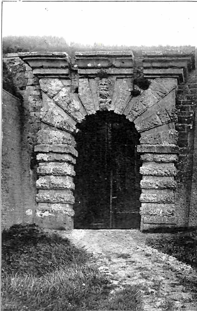
DE OUDE POORT VAN HET FORT RAMMEKENS Cliché G. W. den Boer, Middelburg
