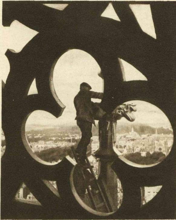
Het gevaarlijke werk van den klokkenstoel in het binnenste van de spits gezien. De schilders verven een kruisbloem van een der zes topgevels, waarop de spits rust.
