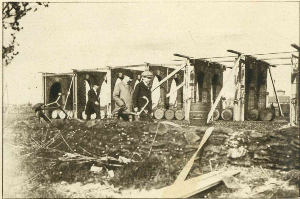
De achterbouw der kelders.
