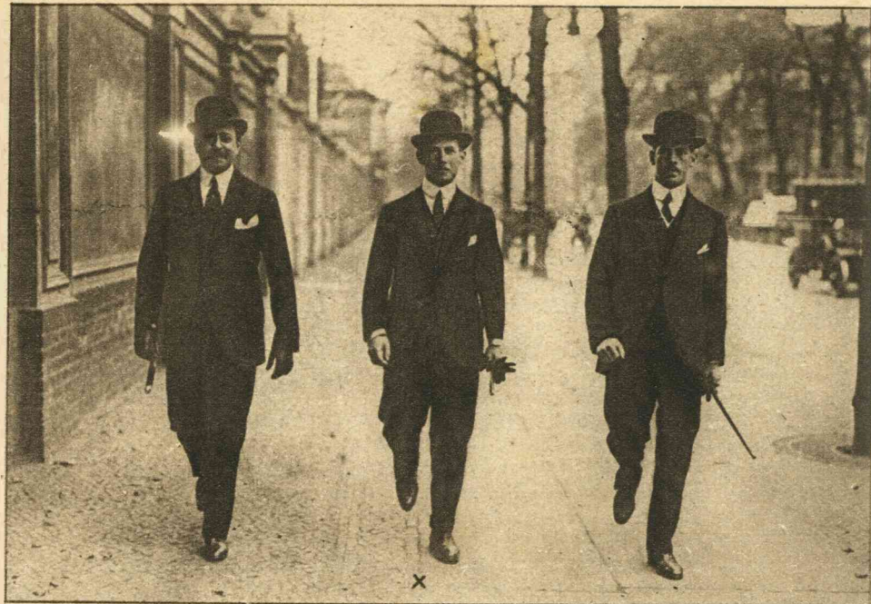
DE NIEUWE KONING VAN GRIEKENLAND.
